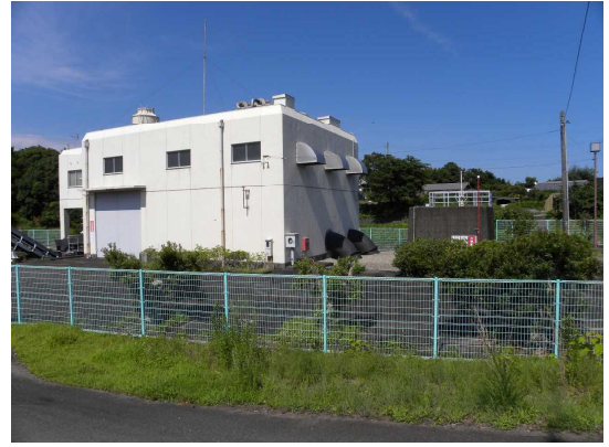
写真2.3：排水機場全景（南面，西面）
