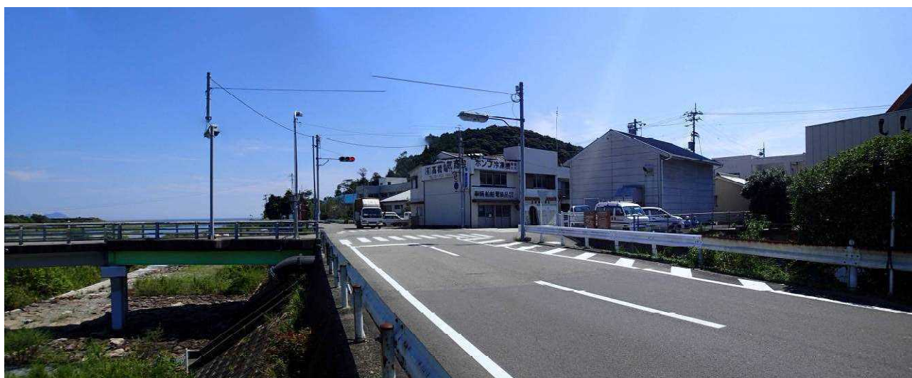
写真1.1：排水機場全景
