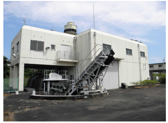
写真2.5：傾斜コンベア
