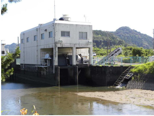
写真2.2：排水機場全景（東面，北面）
